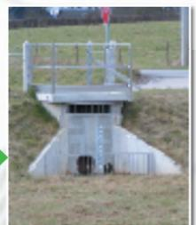
Vous pourrez observer un ouvrage en béton appelé "ouvrage de fuite" permettant la vidange de l'ouvrage en 24 heures environ (cf. journal n°1 ou site internet) afin d'être efficace pour des pluies successives.
