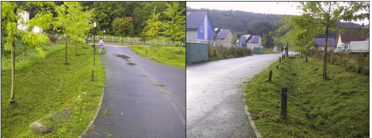
**Photos n°4 et n°5** : Mise en place de noues de collecte et de stockage des eaux pluviales
